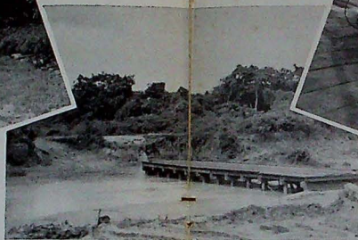
Puente sobre el río Guarío, en el camino que va al "Roble Nº 1".
