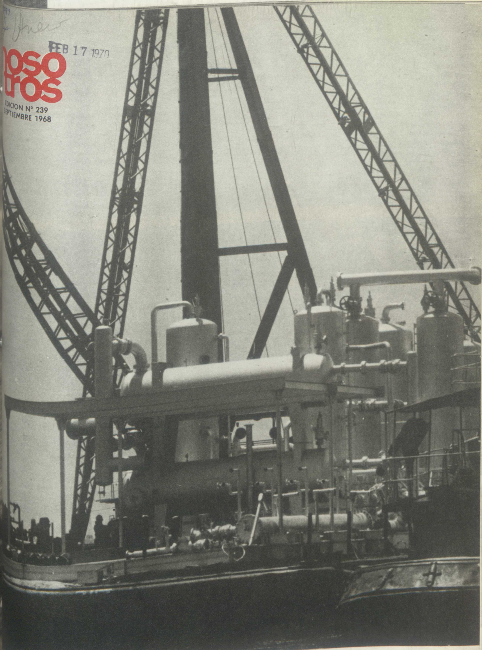
Portada En tierra y ensambladas por "paquetes" las esta- ciones de flujo se van armando sobre el lago como un gigan- tesco pecabozas
