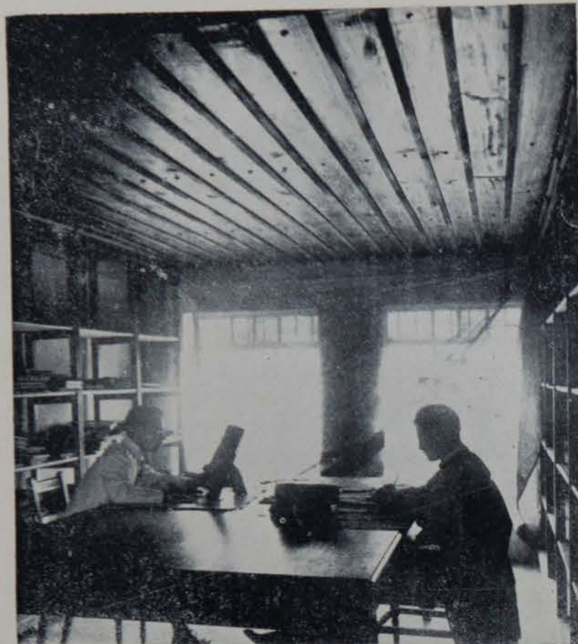
Aspecto de una de las cámaras de aire construidas en el Archivo Nacional.
