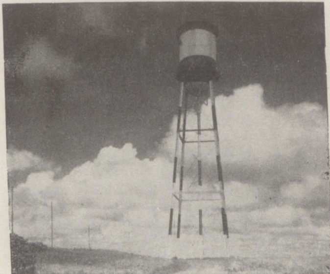
Estanque de agua técnicamente clorinada.
