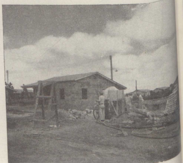
Fabricando bloques de concreto para fabricación de casas.
