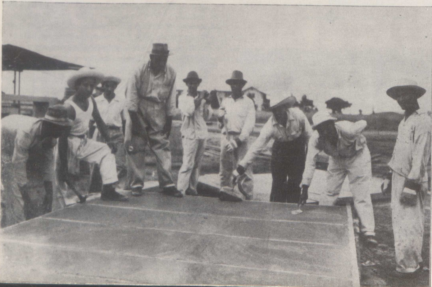
Jesús Travieso, captado por nuestro fotógrafo Yrureta mientras construía una acera con su cuadrilla.
