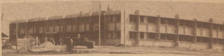
Nuevo edificio para las oficinas de Lagunillas
