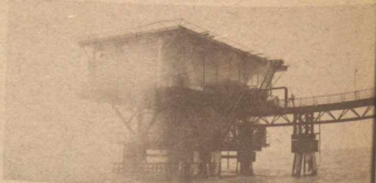
Apagafuegos automático en estaciones de flujo
