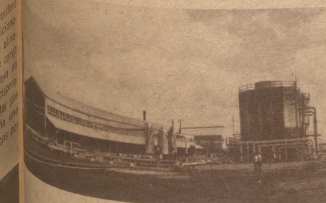
Planta de Compresión de West Guara.
