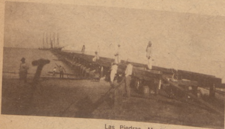
Las Piedras. Muelle en construcción.
