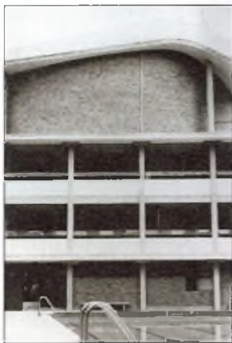
Vista del colegio desde el área de la piscina, sede de La Floresta
