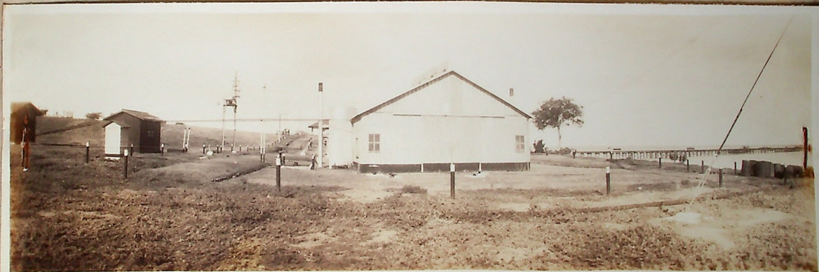
Estacion de cemento
